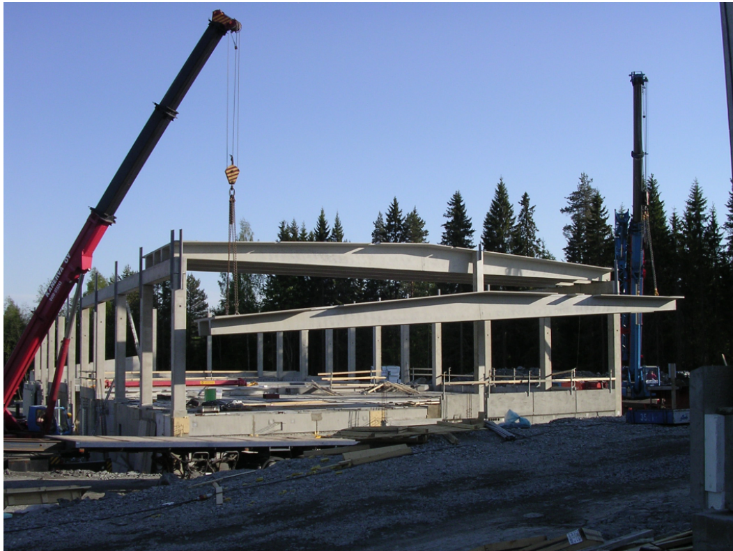
Kuva 39. Kahden nosturin yhteisnosto.
