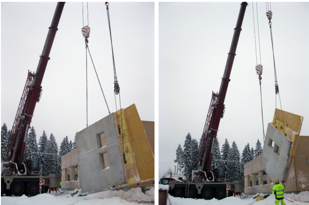
Kuva 40. Elementin kääntö kääntöpyörän avulla yhdellä ajoneuvonosturilla.
