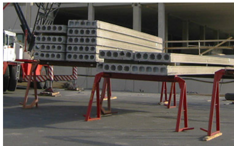
Kuva 8. Ontelolaatat voidaan varastoida erillisten telien päälle.
