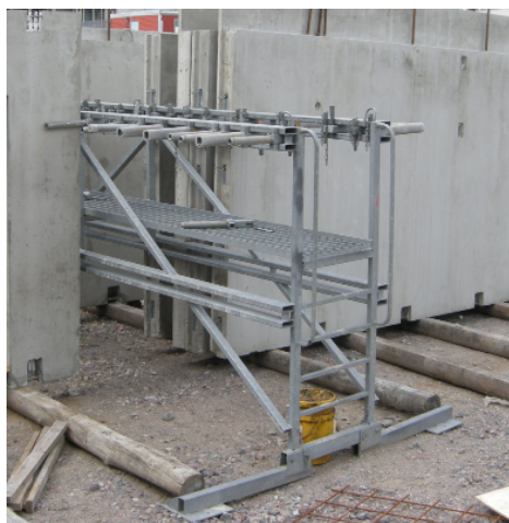
Kuva 10. Kampateline eli elementtifakki.
