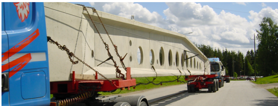
Kuva 29. Harustettu palkki. (Kuva: Juha Vasara)
