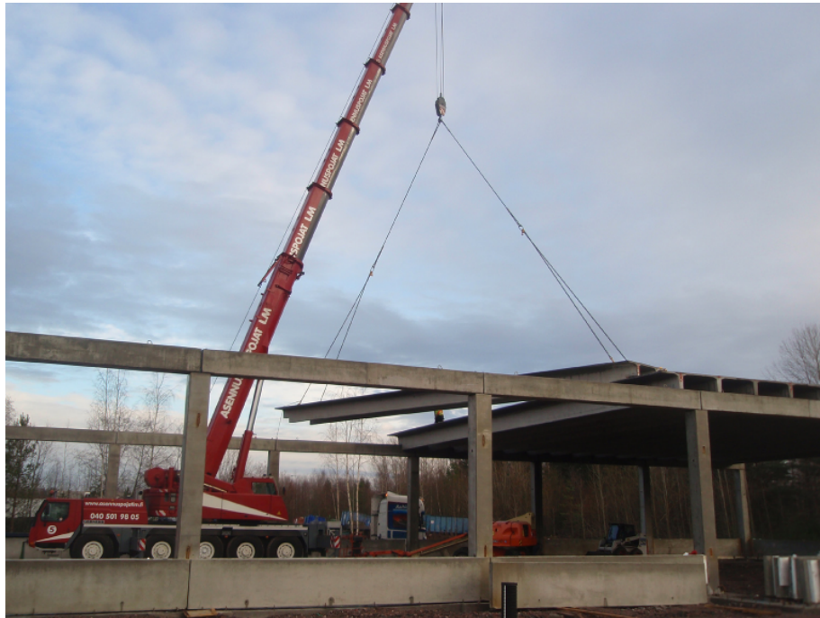
Kuva 32. TT-laatan nosto. (Kuva: Voller Oy)
