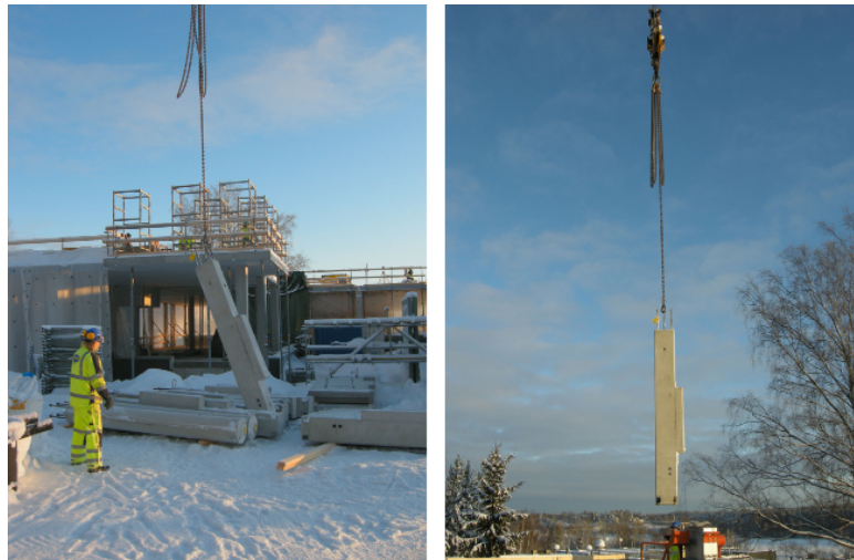
Kuva 27. Pienen pilarin nosto pilarin päässä olevasta nostoankkurista yhdellä nostonaksella.
