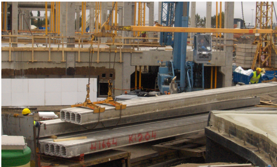
Kuva 20. Ontelolaatan nosto nostopalkilla ja tuplasaksilla.
