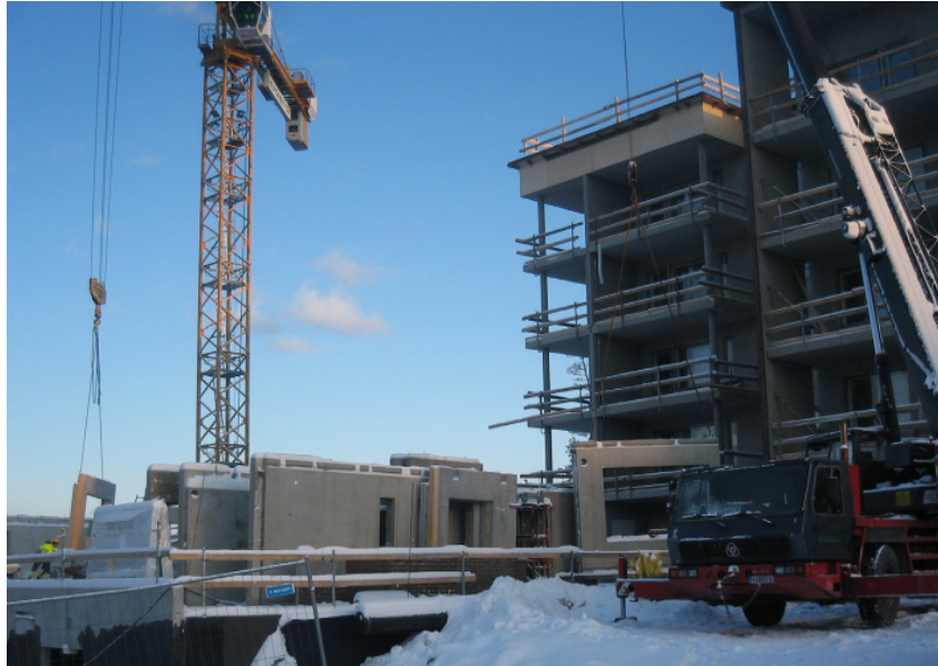
Kuva 1. Seinäelementin nosto torninosturilla.
