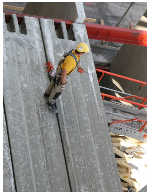
Kuva 36. Norjassa käytetty ontelolaattojen väliin kiinnitettävä turvalajajaiden kiinnityspiste.
