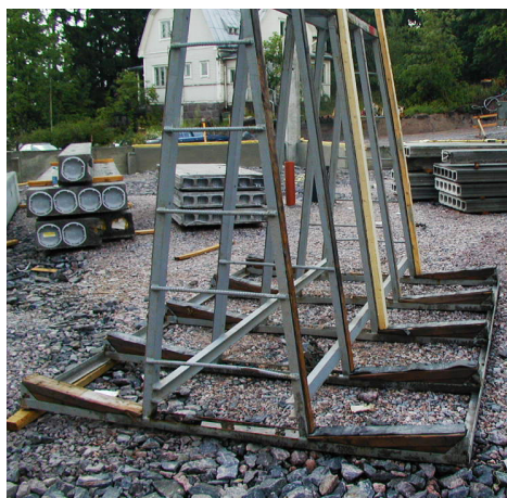
Kuva 9. Seinäelementit voidaan varastoida työmaalla esimerkiksi A-pukkiin. Elementit nostetaan A-pukeista pois vuorotellen kummaltakin puolelta, jotta telineen tasapaino säilyy.
