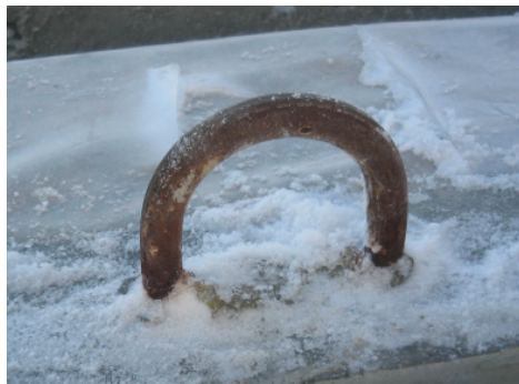
Kuva 11. Nostolenkki seinäelementissä.
