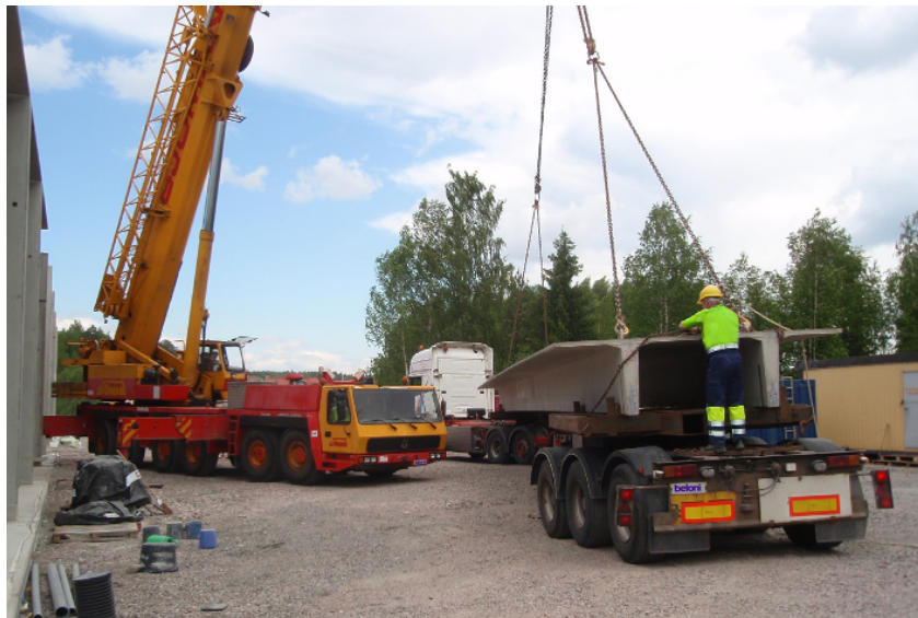
Kuva 7. TT-laatan nosto kuljetusautosta. (Kuva: Voller Oy)
