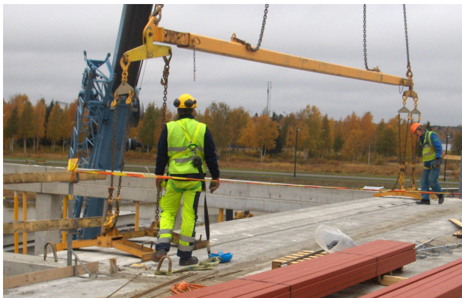
Kuva 30. Ontelolaatan nosto.
