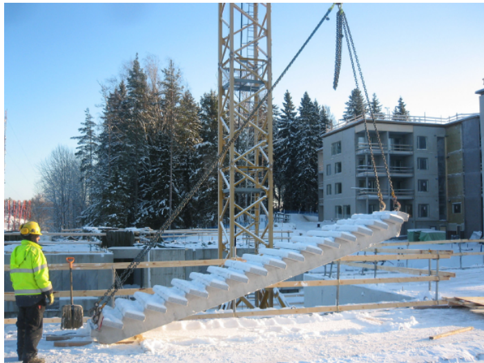
Kuva 34. Suoran porrascalvoelementin nostaminen, askelmien suojaus laudoilla.
