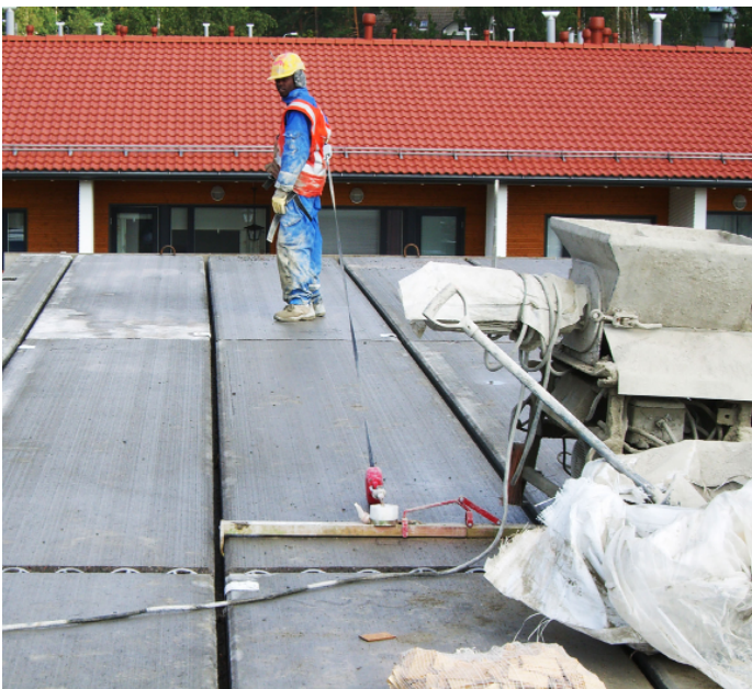
Kuva 35. Turvalajajaiden kiinnityspisteeksi tarkoitettu ontelotarrain.
